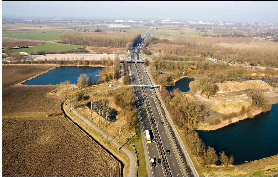
Figuur 71: Bestaande situatie nabij Fort Altena.
