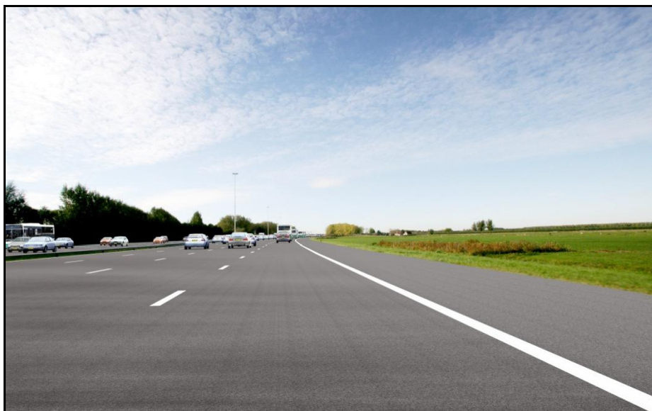
Figuur 72: Impressie situatie in alternatief B (2x4 rijstroken) ter hoogte van Vianen.
