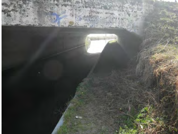
Figuur 12.1: Huidige situatie van het kunstwerk met loopstrook in de Oude Zederik.
