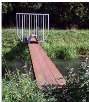
Figuur 12.4: Loopplank voor kleine fauna met voorziening om gebruik door mensen te voorkomen [61].
