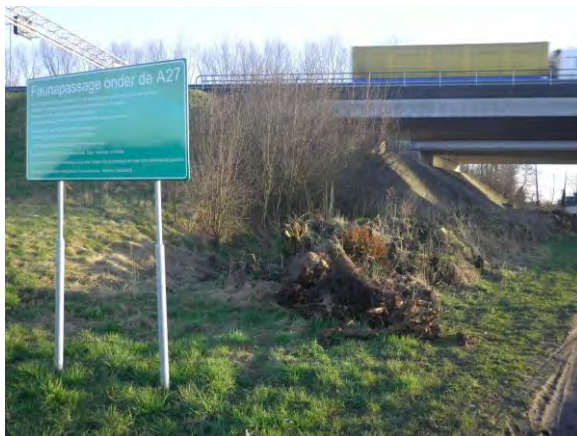
Figuur 4.9 Stobbenwal onder de A27 langs het Merwedekanaal als onderdeel van het MJPO knelpunt UT19.
